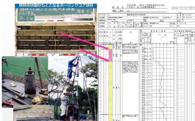
図 12 ボーリング調査とコア・柱状図の例
