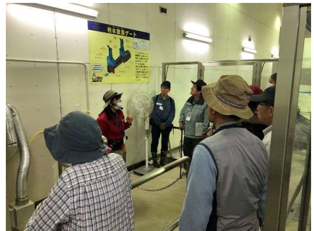
図12 三国川ダム利水放流ゲートの見学
