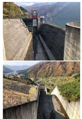
図13 非常用洪水吐
