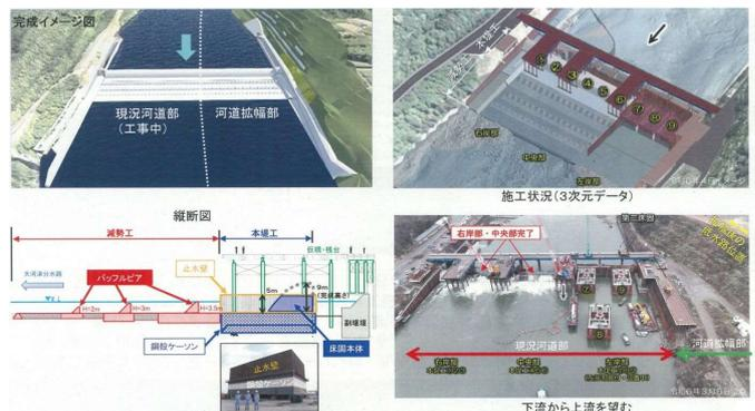
図 6 新第二床固工の施工状況
