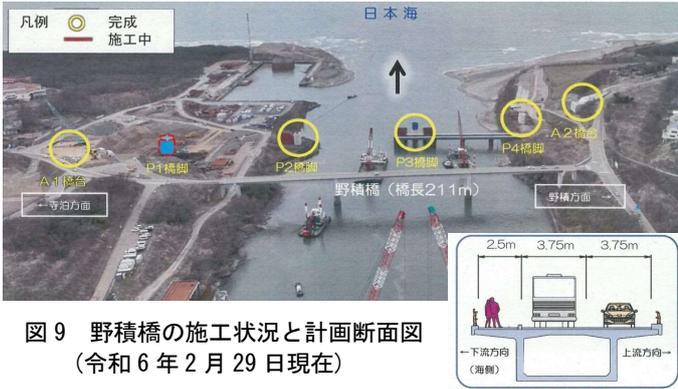
図9 野積橋の施工状況と計画断面図 (令和6年2月29日現在)
