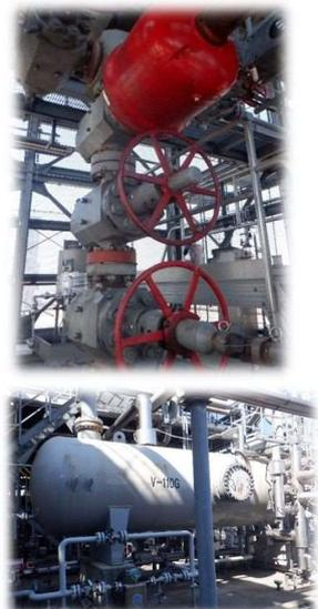
図8 越路原プラントにけるガス、原油、水の処理フローと主な装置(クリスマスツリー・セパレーター)
