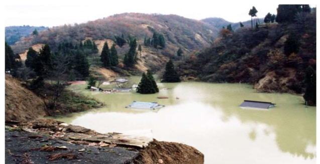
図10 東竹沢の地すべりで発生した天然ダムで水没した家屋（国交省湯沢砂防事務所提供）
