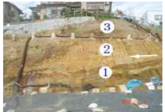
図 13 高町団地北西部の崩落地の復旧工事現場 (2005 年 9 月 10 日撮影)
