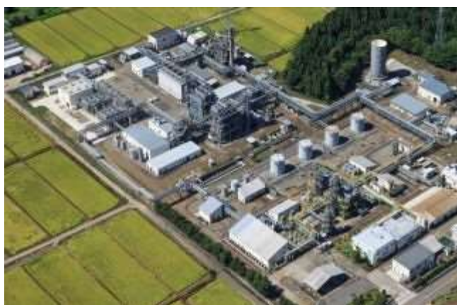
図 5 越路原プラント全体写真
