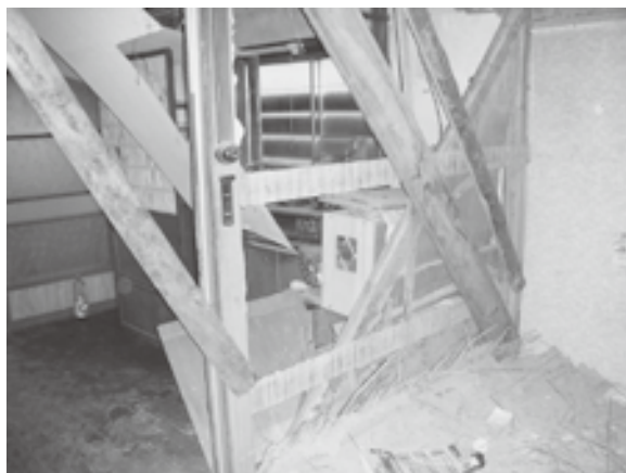
落ちた壁・応急の筋交い（椎谷）
