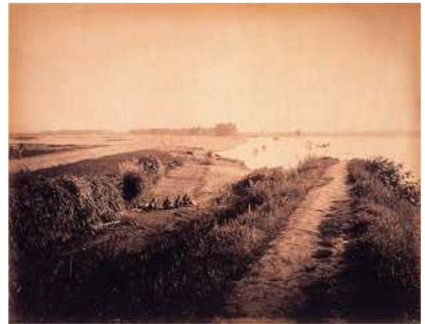
本図八明治二十九年七月中洪水ノ災害二罹リタル信濃川沿岸三島郡中野島村大字中島地先堤防破壊シ郷里一円荒蕪ニ帰シタル惨状ニシテ出水後二十七日ヲ経撮影シタルモノナリ(越路町) 【いずれも 大河津分水双書第1巻p43より転載 写真は土木学会附属土木図書館所蔵】
