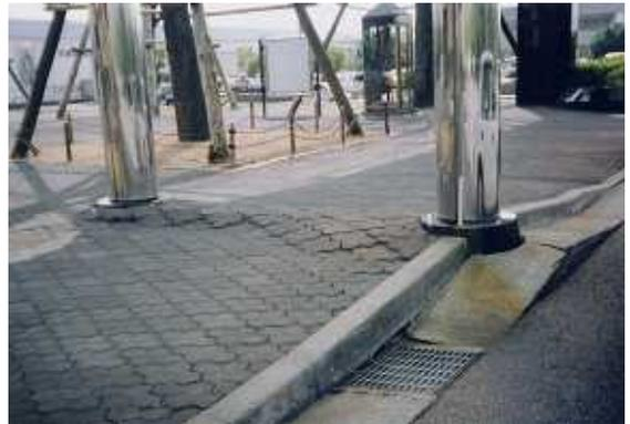
写真1 下に軟弱層がある場合、わずかな荷重(盛土)でも沈下が生じる(新島県立自然科学館タクシー乗り場)。
