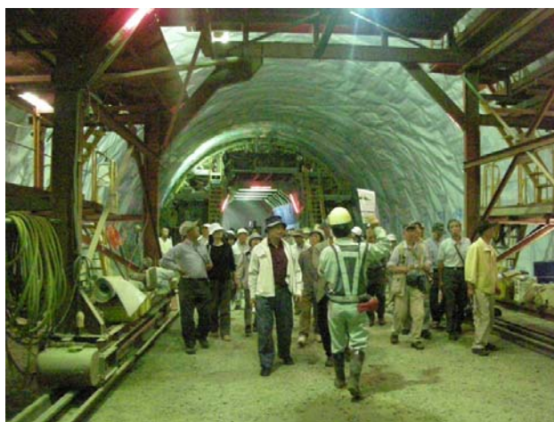
⑥椎谷岬トンネル工事現場
