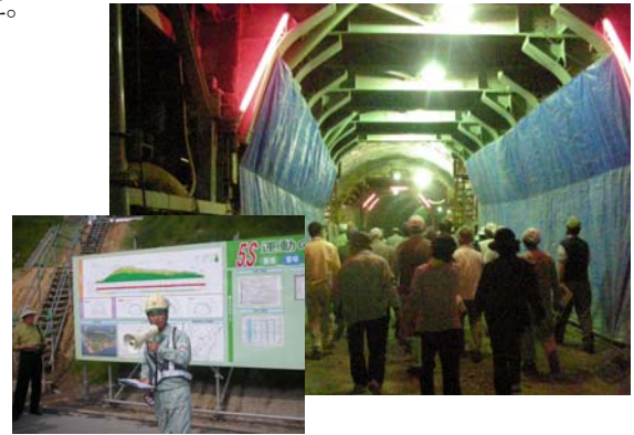
図11 椎谷岬トンネル現場見学
