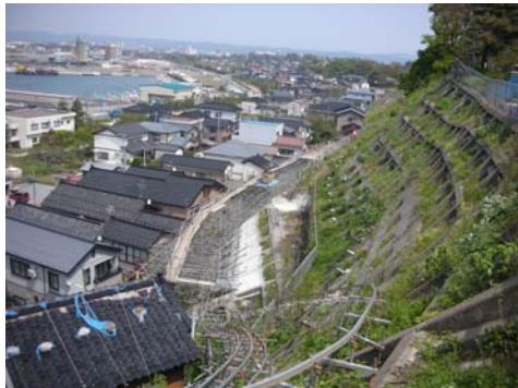
図8 番神堂前の急崖の復旧工事
