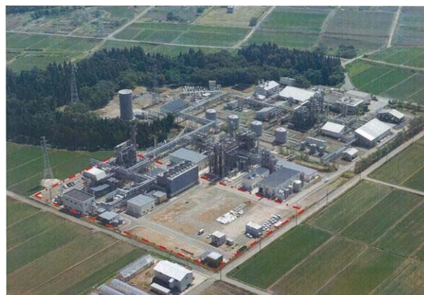
図2 越路原発電所とプラントの全景
