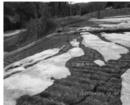
図 8 融雪後に確認された地面のクラック（長野県栄村）
