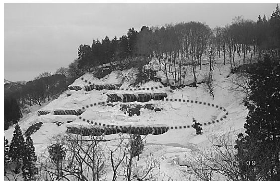
図4 雪崩予防柵上部・中間から雪崩発生（新潟県十日町市）
