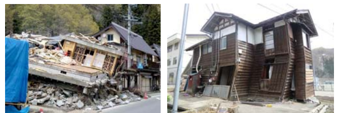
写真-6 横倉地区の家屋被害
