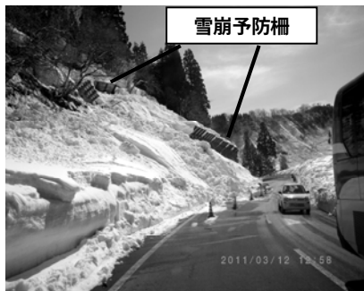
図 5 雪崩予防柵上部斜面から生じた雪崩が道路を埋積（新潟県十日町市）
