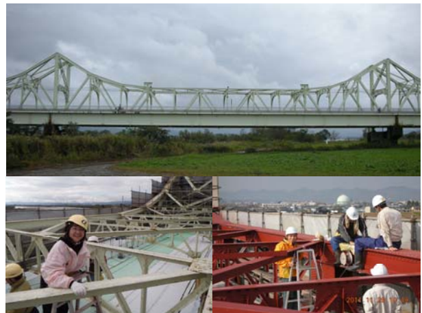
長生橋と見学会・錆止め塗装後の粘土による型取り作業
