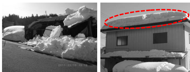
図2 長野県北部地震で落下した屋根雪（長野県栄村）
