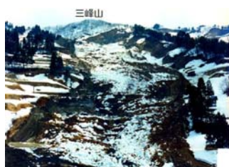
図A 虫亀の地すべり（1980年4月） 災害発生直後の状況（新潟県長岡地域振興局提供）
