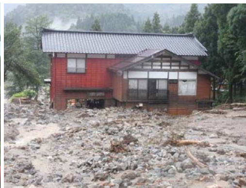
土砂災害(土石流)による被害(南魚沼)
