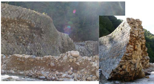
図-7 登川檜倉砂防堰堤の被災
