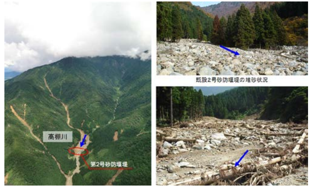
図-8 高棚川の崩壊と堰堤の堆砂状況
