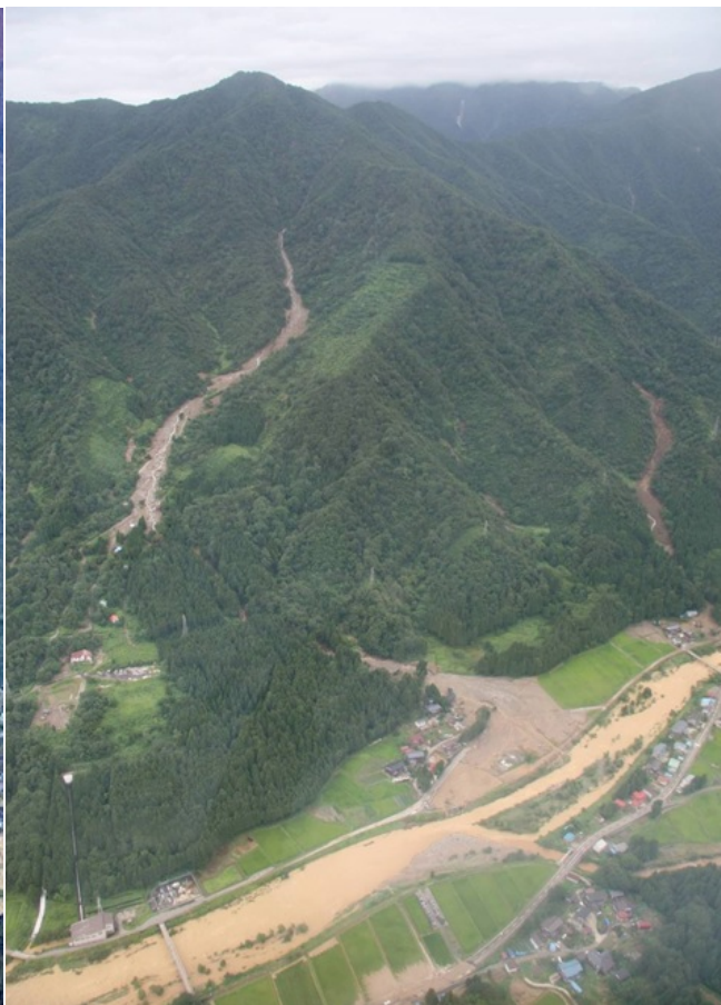
H23.7 新潟福島豪雨 三国川土沢・高平沢土石流
