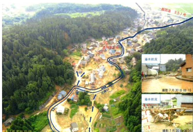
写真1 乙吉地区被災状況
