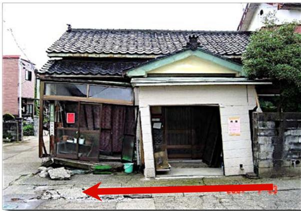
図14 地盤の表層すべりによる被害
