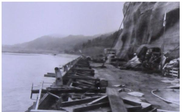
図 2~5 国道改修工事中写真 川側に棧橋形式に張り出して道路を拡幅している様子(昭和 50 年代初期)
