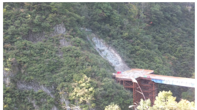
図 14 5号橋梁 P1 橋脚掘削工事
