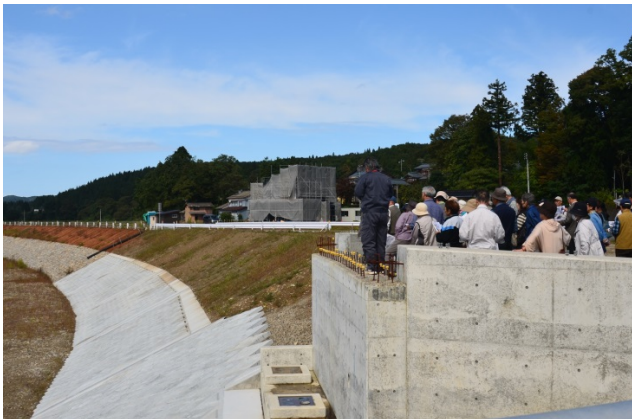
図7 田屋地域の橋梁工事と復旧された県道
