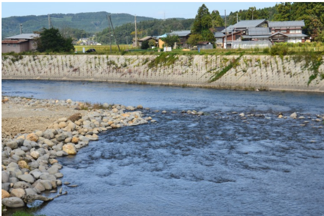
図6 決壊した河岸は頑丈な護岸で復旧(江口地域)
