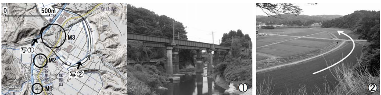
図3 (左) 塚野山付近の残丘M1~M3 (中) 塚野山掘割り (右) 渋海川の旧流路 写①、写②は写真①、②撮影地点、①は信越線渋海川橋梁付近で、②は塚野山東方台地上から
