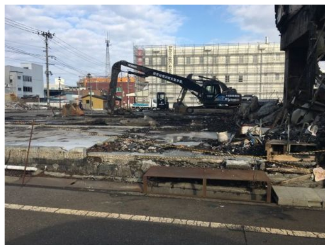
瓦礫の撤去が進む被災地 (2017.2.15)
