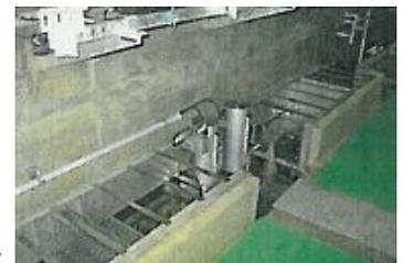
図3 漏水量計と揚圧力計
