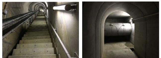
図4 監査廊の急な階段と放流管(流量計室)
