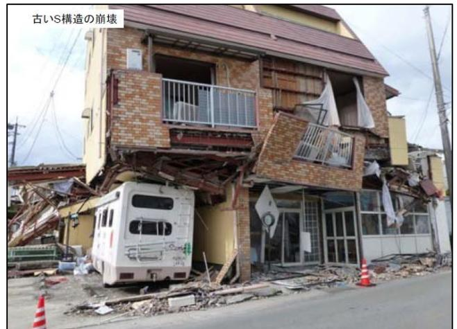
図6 強振動による被害(旧耐震...しかし新耐震対応の建物も2回の震度7の揺れで壊れている)
