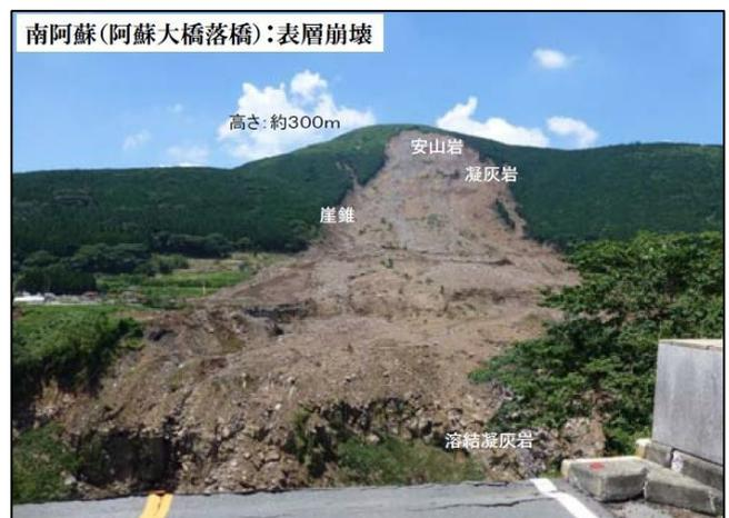
図 2 表層崩壊による阿蘇大橋の落橋
