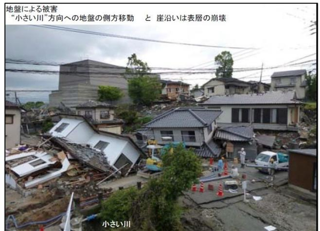
図5 地盤による被害(側方流動と崖沿いの崩壊)
