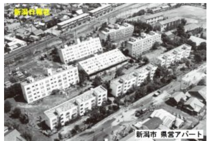
図7 新潟地震 県営アパートの倒壊 新潟市白山浦（新潟日報社）
