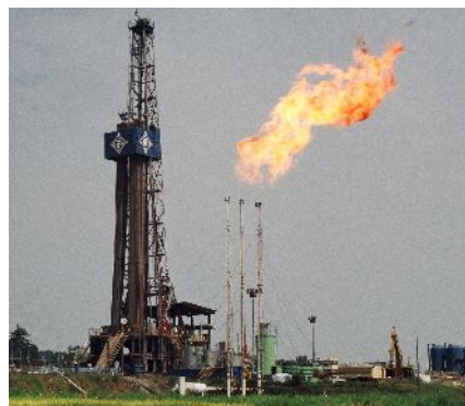
坑井掘削(試ガステスト)
