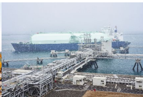
直江津LNG基地
