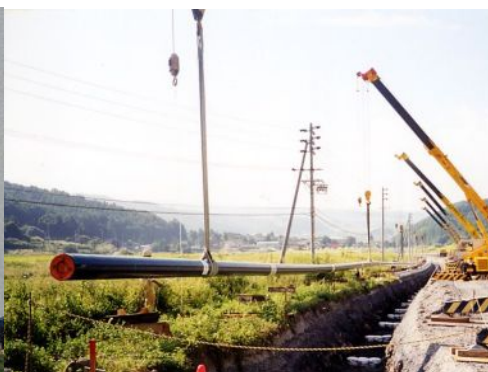
パイプラインの敷設
