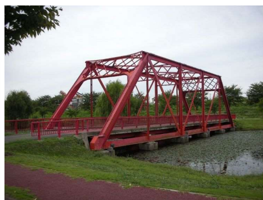
旧越路橋保存橋
