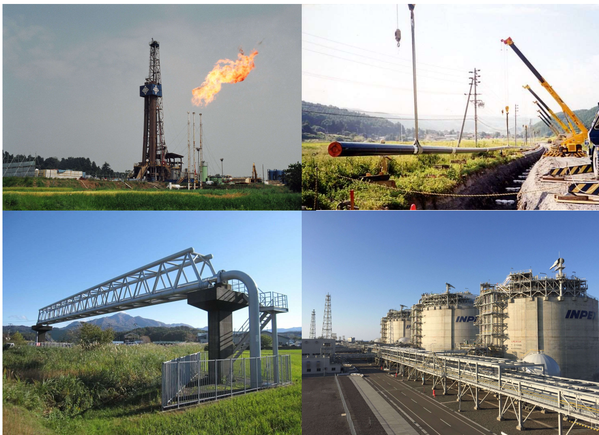
上：坑井掘削(ガステスト) 下：パイプライン(専用橋) 上：パイプラインの敷設 下：直江津LNG基地
